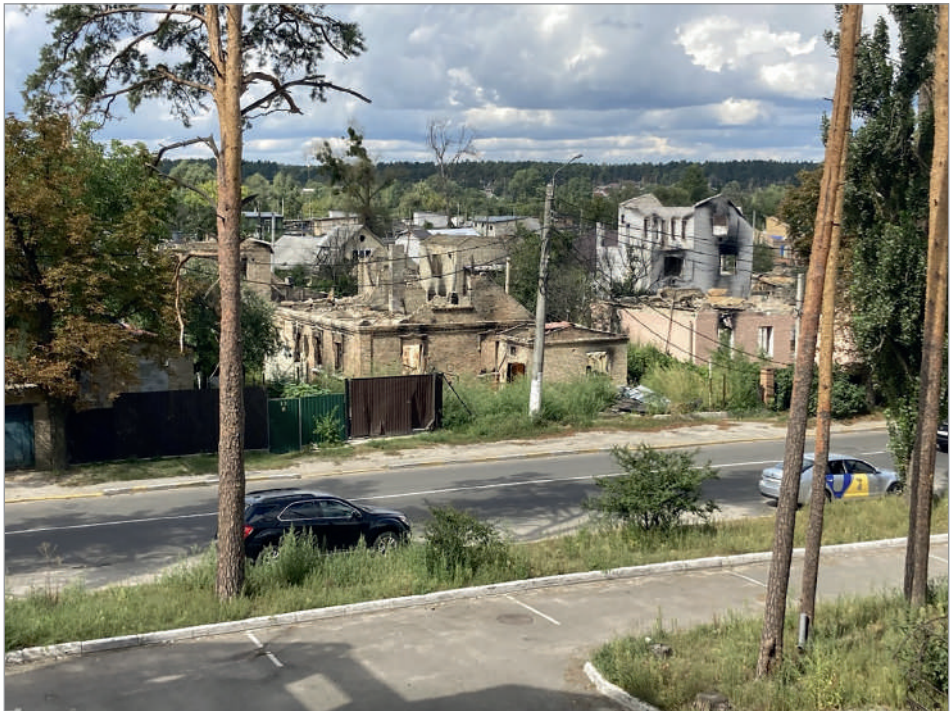
Case ale locuitorilor din Irpin, după bombardamentele armatei rusești.
