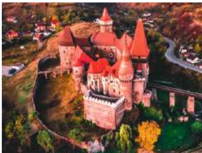
Castelul de la Hunedoara, vedere aeriană.
