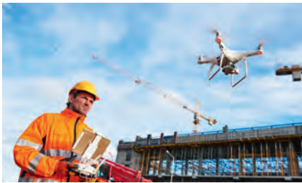
Verificarea cu drona a unei construcții
