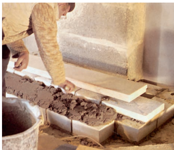
Figura 8. Se pregătește patul de mortar de var al plăcii de bază, care se poate observa în fundal
