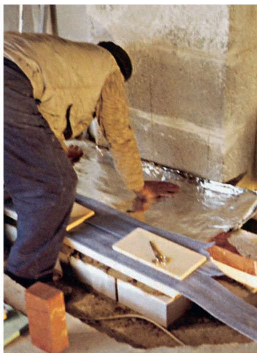
Figura 11. Așezarea foliei de aluminiu termo-reflectorizantă. În prim-plan se observă placa de marmură acoperită
