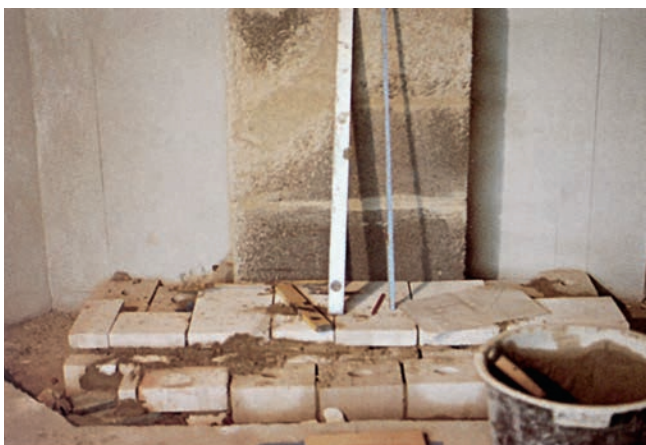
Figura 7. Construirea soclului șemineului deschis; în prim-plan se poate observa suprafața de reazem a plăcii de bază. În fundal se vede blocul coșului de fum
