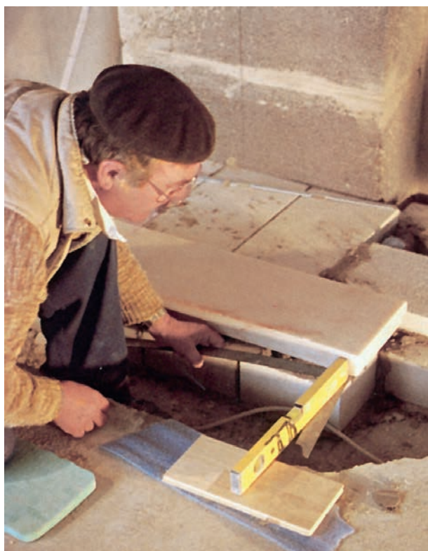
Figura 9. Nivelarea manuală a plăcii de bază (muchia inferioară trebuie poziționată în așa fel încât aceasta să ajungă la aceeași înălțime cu planul superior al pardoselii). În prim-plan se vede bolobocul așezat pe o bucată de parchet (sub parchet a fost amplasat un suport provizoriu care reprezintă grosimea rostului)
