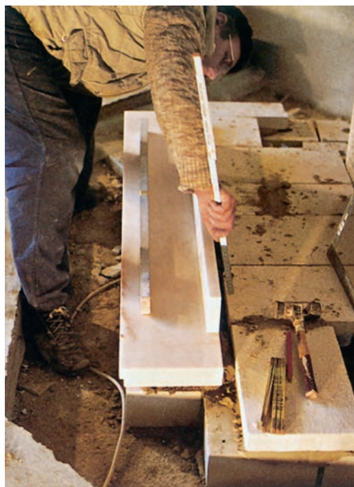
Figura 10. Poziționarea provizorie a cadrului inferior pentru a stabili înălțimea fundului spațiului de ardere
