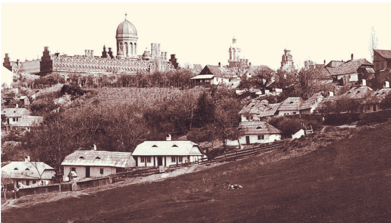
Panoramă a orașului în 1875, cu Mitropolia ortodoxă în construcție.
